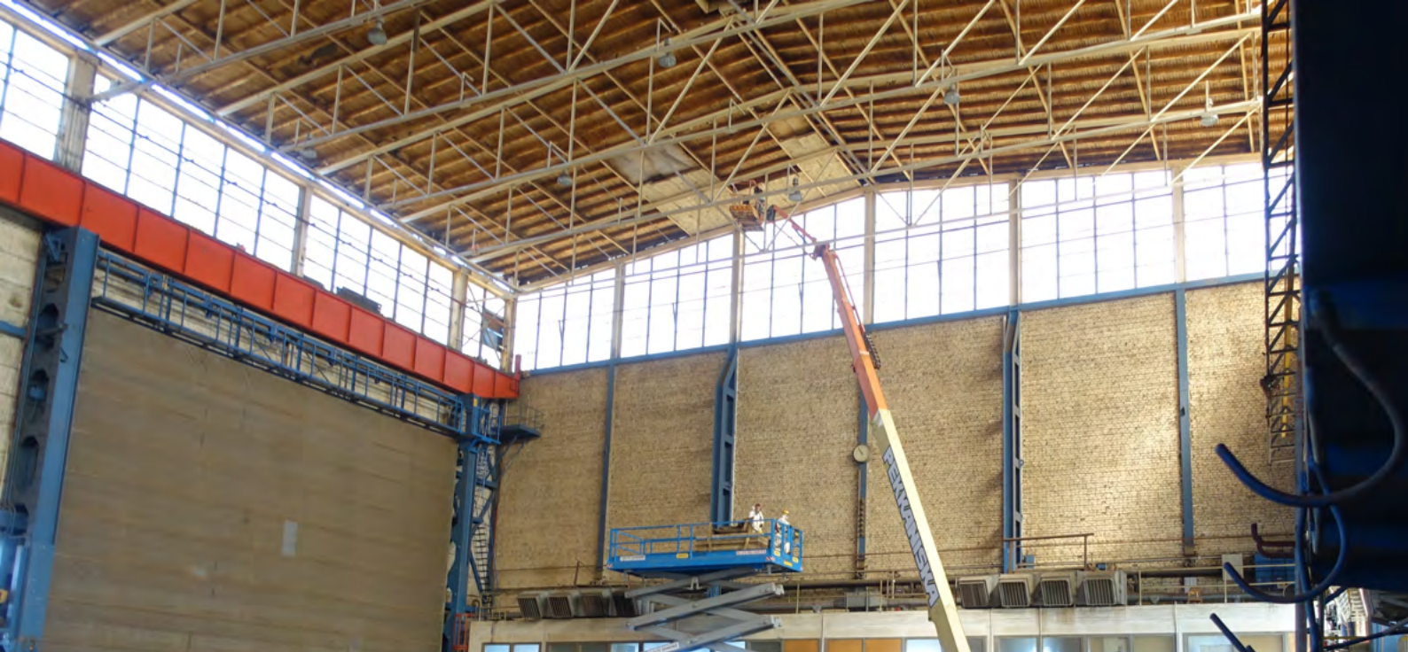
Telakkahallin katon vanhoja eristeitä puretaan eristyksen uusimisen tieltä. Kuva: Teemu Heikkinen.
