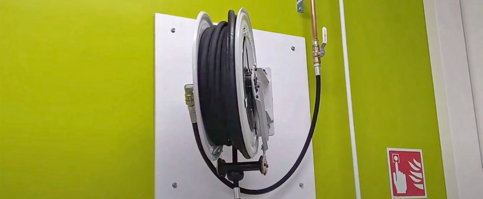
Letkukelat ja liittimet ovat yleisiä vuotokohtia. Kuva: Petri Lähde.
