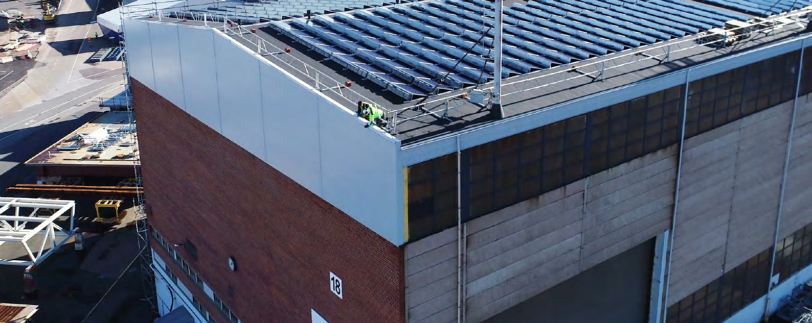
Telakkahallin päätyikkunat on korvattu eristävämällä seinärakenteella. Kuva: Kristiina Kortelainen.
